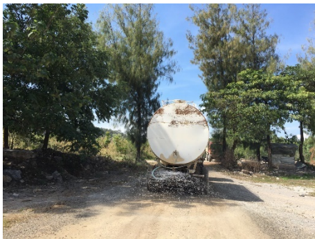
รูปที่ 2-10: การฉีดพรมน้ำบริเวณเส้นทางขนส่งแร่
